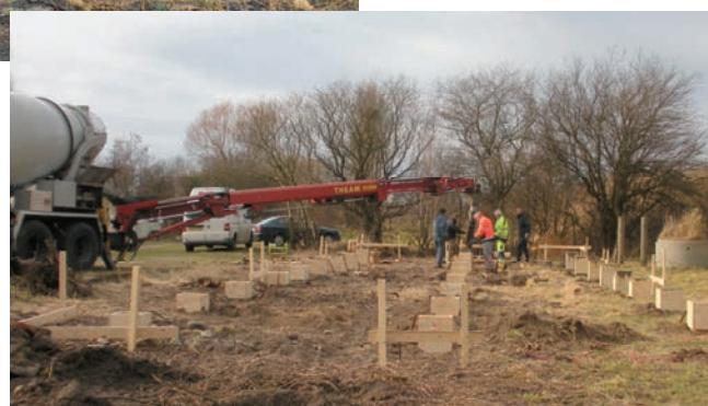
36 punktfundamenter blev snildt fyldt med beton
